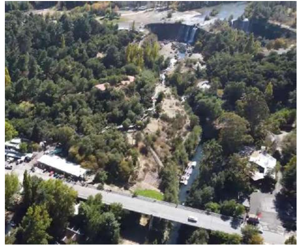
Puente Salto del Laja.
